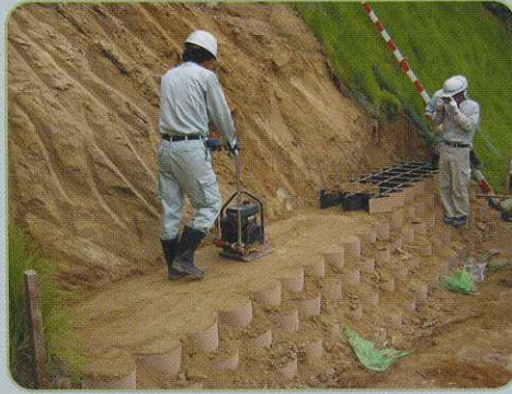
4. 転圧・繰返し 補助枠を外し転圧。2と3を繰返し、天端まで仕上げる。
