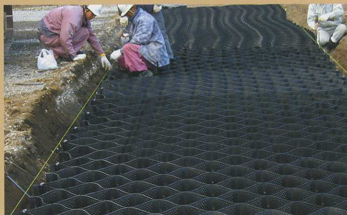
発注者：静岡県東部農林事務所 工事名：障害防止東富士地区抜川1工事
