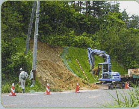
1. 整地 掘削・基礎面修正
