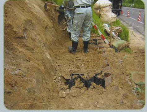
3. 撤出し 充填材と裏込材を投入。次工程の転圧を考慮して余盛する。
